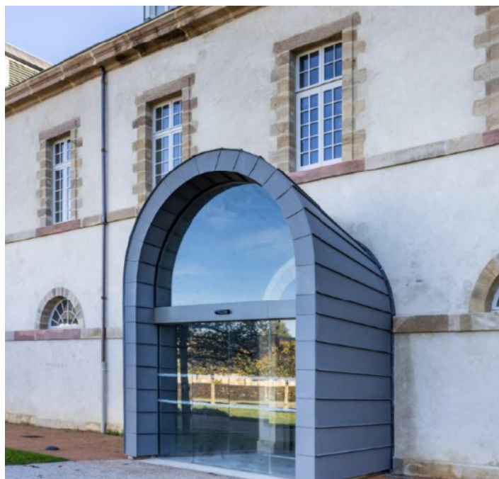
Vue extérieure du sas d'entrée
